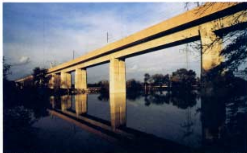
Viaduc sur le Cher
