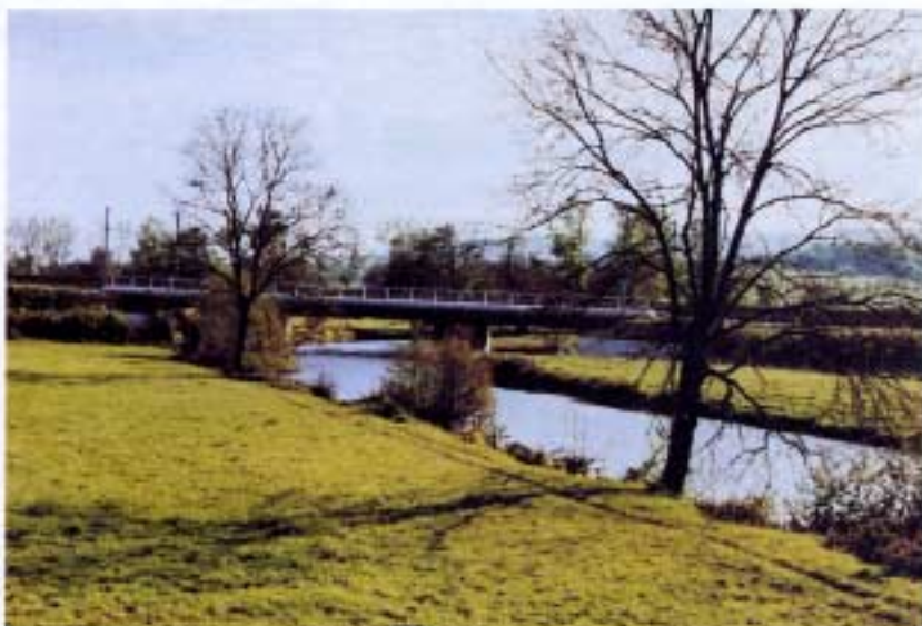
Ouvrage hydraulique de franchissement de l'Oranne (Eure et Loir)
