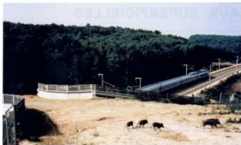
Passage supérieur à grande faune, en forêt de Vilroye (Savoie)
